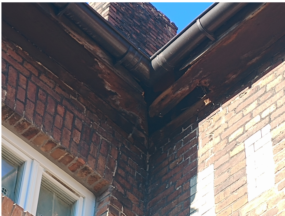
Całkowicie zniszczona podbitka dachu.
