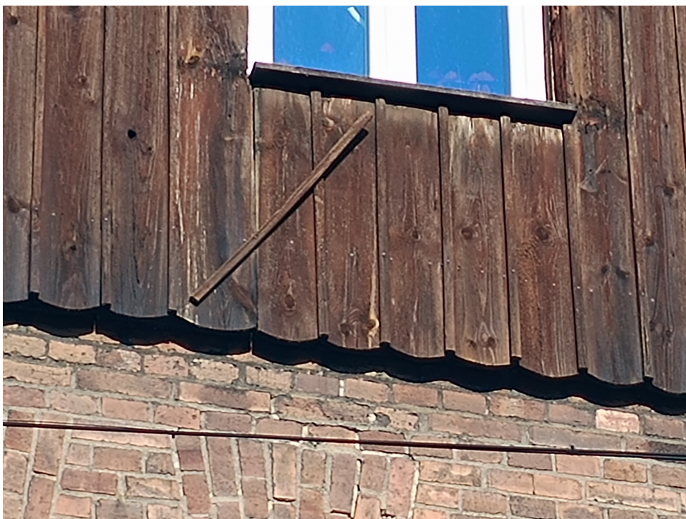
Uszkodzenia drewnianej okładziny ryzalitu.
