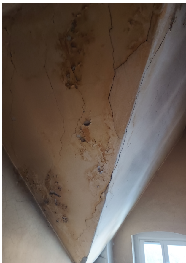
Fot. 11, 12 Ślady po zalaniach na klatce schodowej od strony podwórza.
