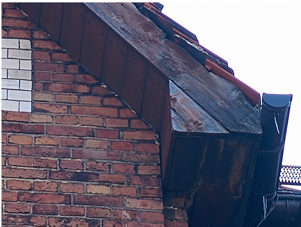
Uszkodzona podbitka dachu.
