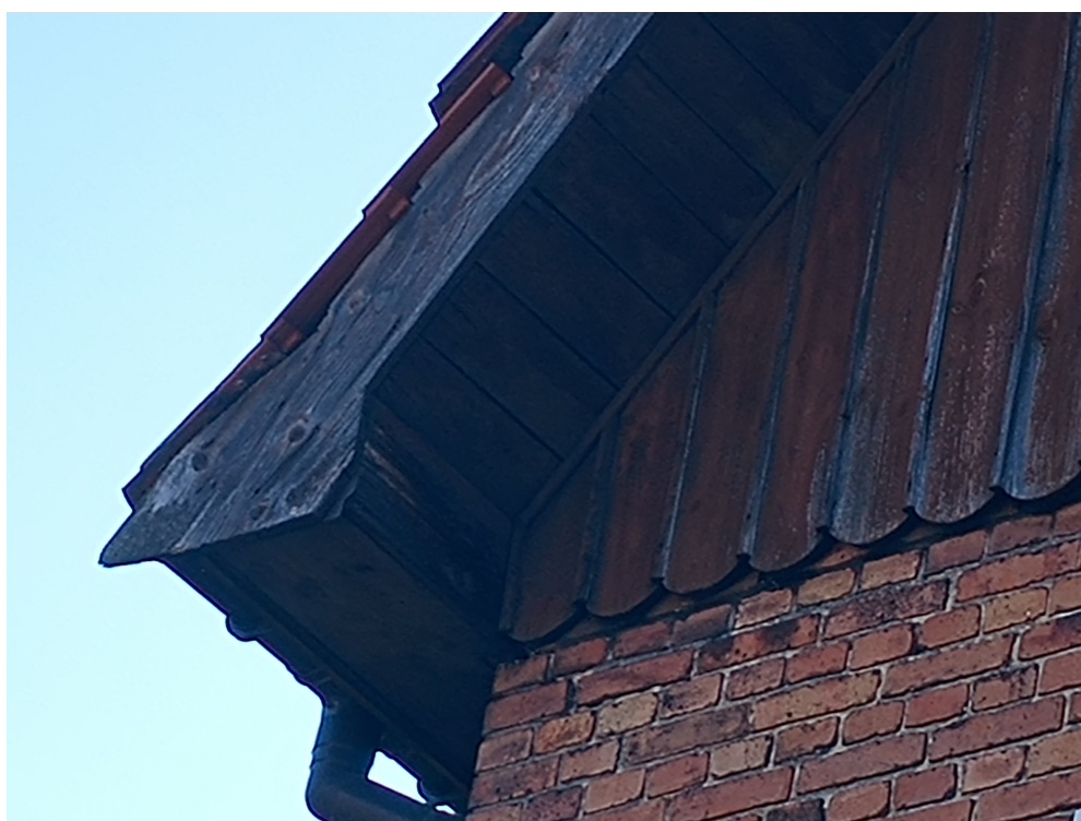
Odbarwione listwy licujące szczyt, uszkodzenia listwy czołowej szczytu.
