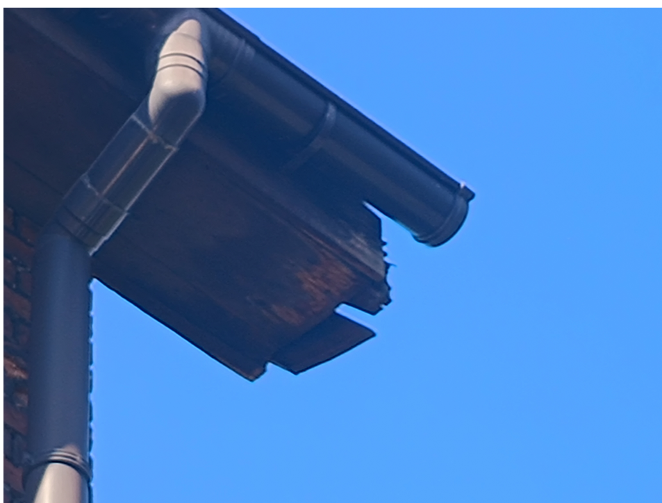
Fot. 14 Uszkodzony fragment drewnianego gzymsu dachu.
