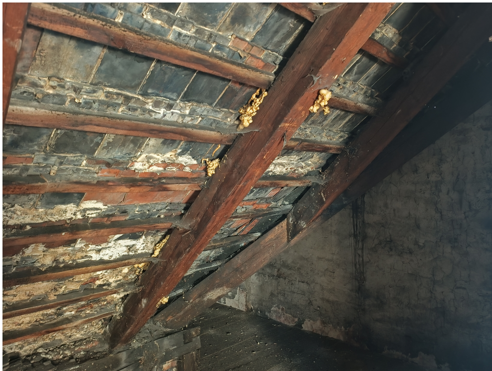
Uszczelnienie zaprawa pokrycia dachowego.
