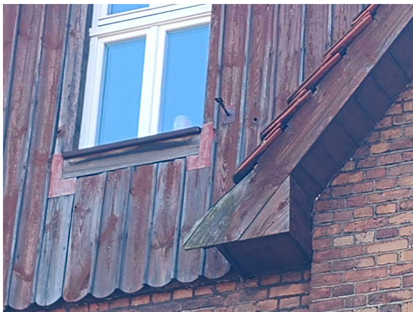
Fot. 18 Fragment drewnianej okładziny szczytu. Odbarwienia na całych płaszczyznach.
