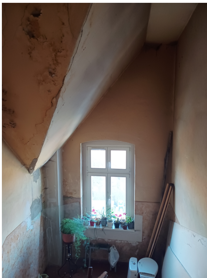
Fot. 11, 12 Ślady po zalaniach na klatce schodowej od strony podwórza.
