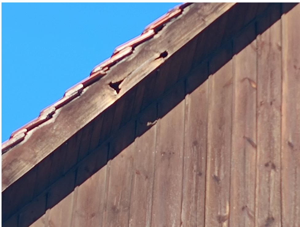
Uszkodzona listwa czołowa ryzalitu.
