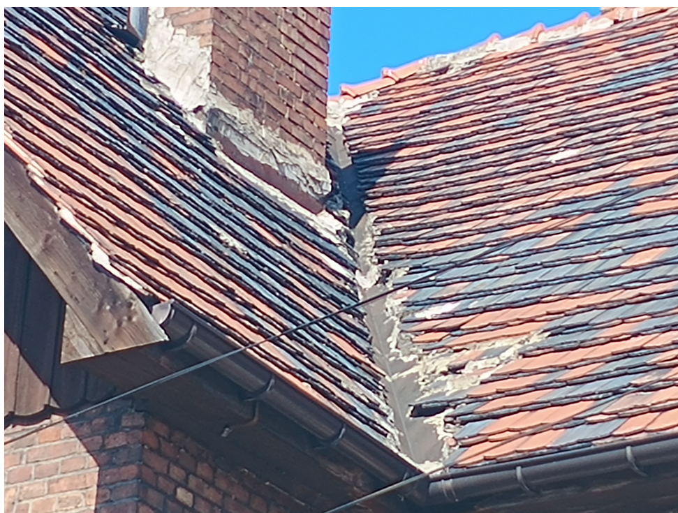
Fragment zniszczonego pokrycia dachowego oraz komina.
