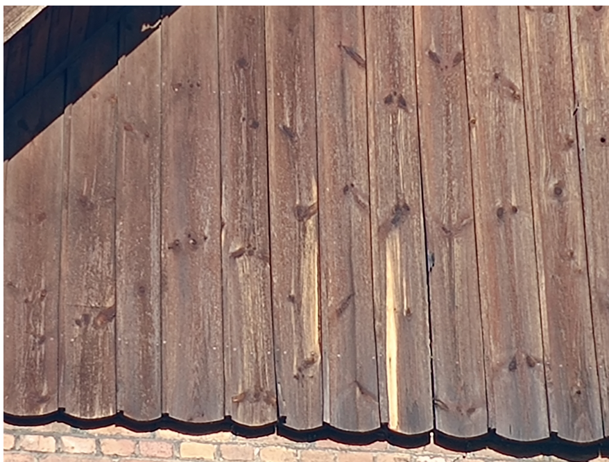
Fot. 21 Widok na okładzinę szczytu, odbarwienia oraz drobne uszkodzenia listew.
