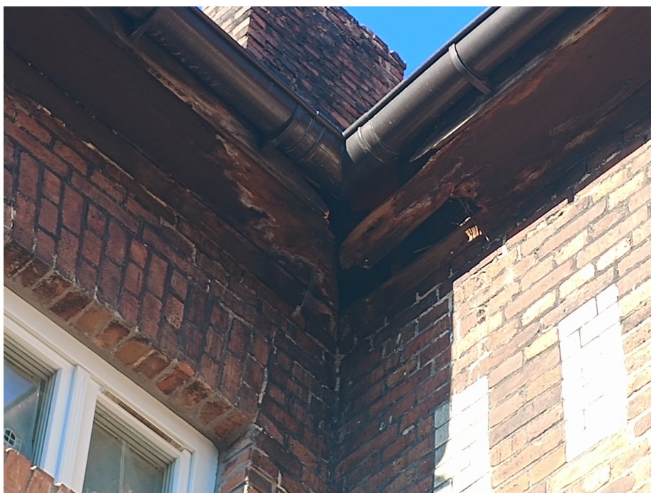
Fot. 13 Całkowicie zniszczona podpitka dachu.
