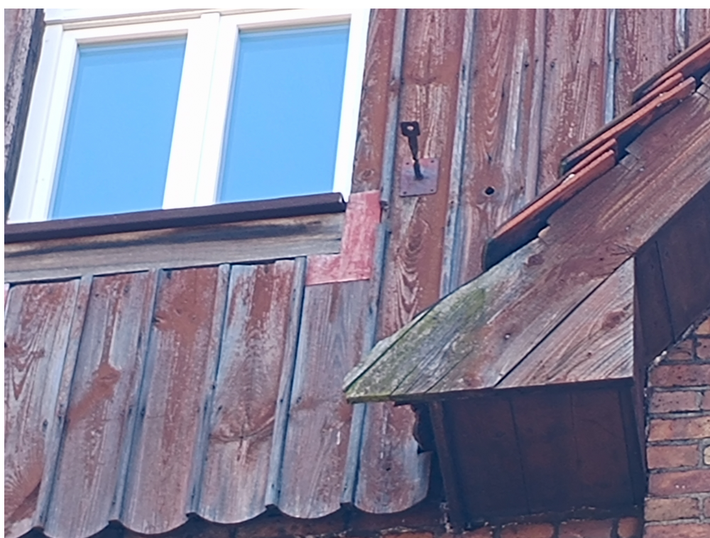
Odbarwienia okładziny szczytu ryzalitu.
