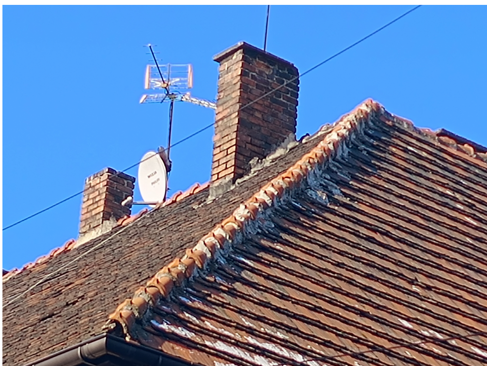
Doraźne prace naprawcze gąsiorów z ubiegłego okresu.
