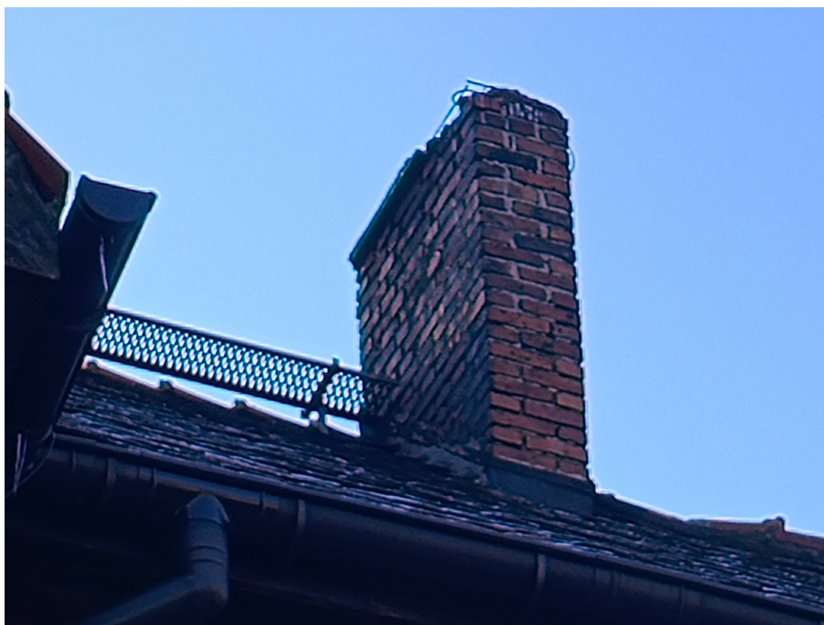
Fot.23 Przykład uszkodzeń komina. Wychylenie od pionu, brak spoinowania, obluzowane cegły, zniszczona czapa. Całość pokryta nawarstwieniami atmosferycznymi.
