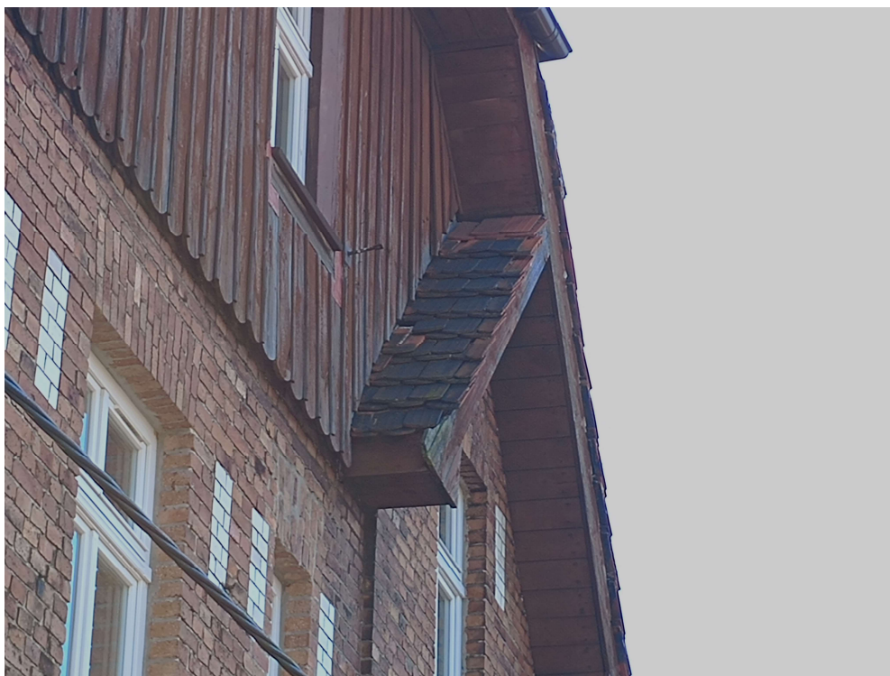
Niejednorodne pokrycie dachowe.
